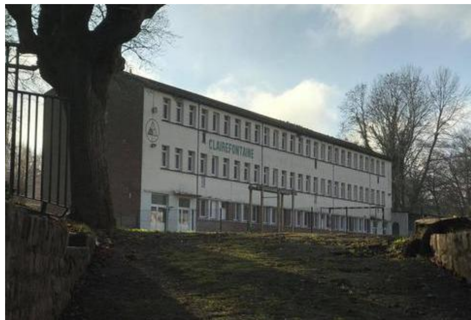
Le premier bâtiment à reprendre vie devrait être l'ancien internat, où l'école Montessori d'Hermaville doit arriver pour la rentrée 2021.
